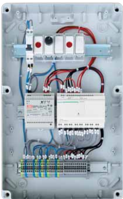
Esempio di Plc cablato Beispiel einer verkabelten SPS
